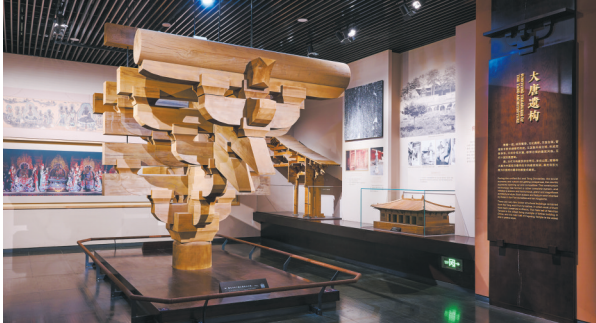
“土木华章”展厅 1:1 比例模型复原唐代五代佛光寺木结构斗拱
