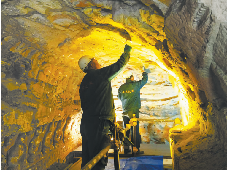
对洞窟壁面进行加固
