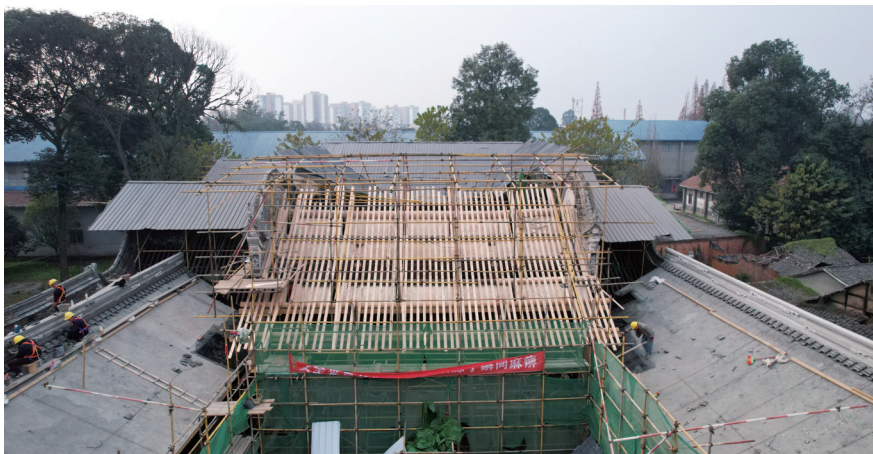
黄州会馆保护修缮工程现场
