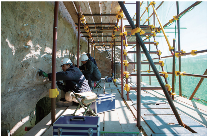
第38—40窟保养维护工程
