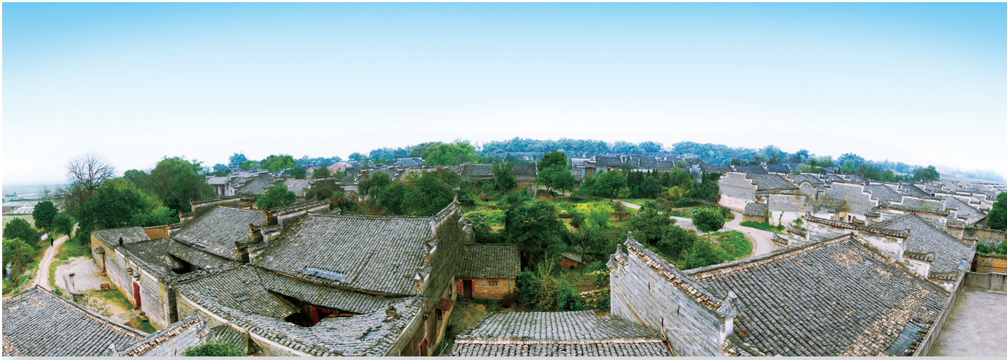
吉水县燕坊古村全景
