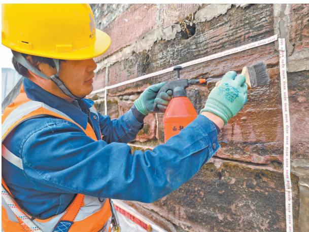
拱桥墙面污染物人工清理
