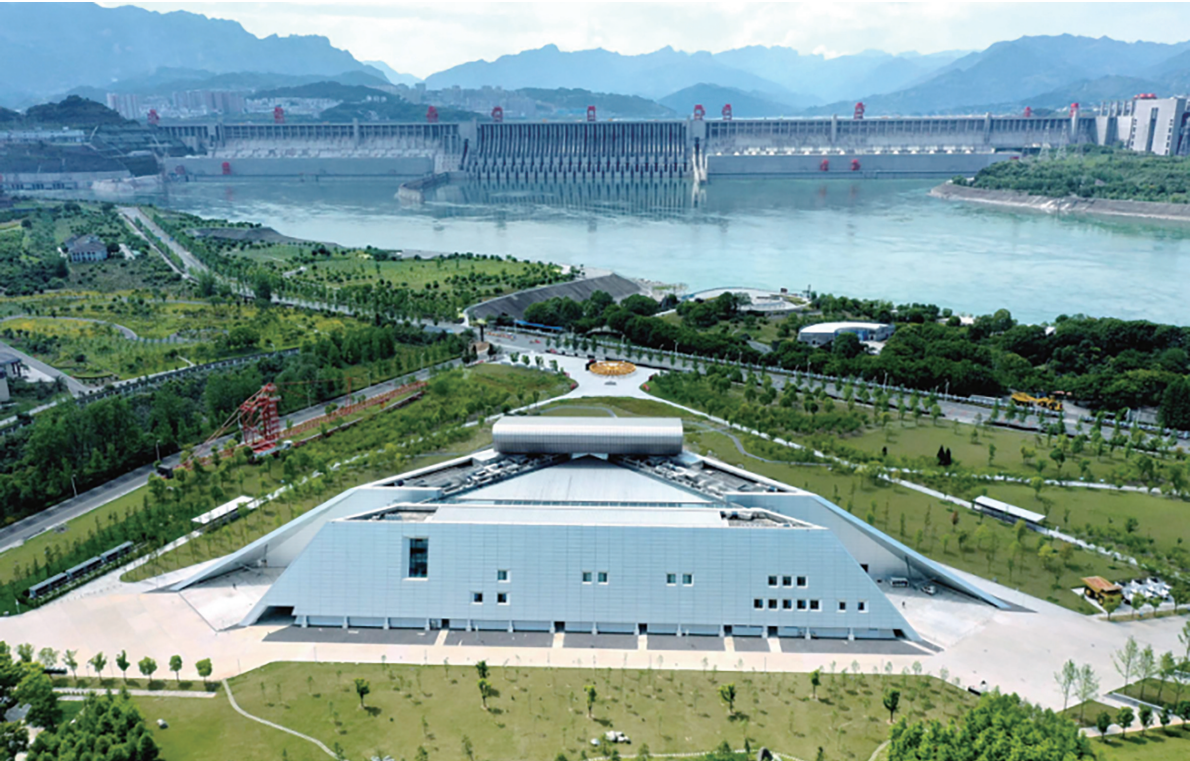
三峡工程博物馆外景
