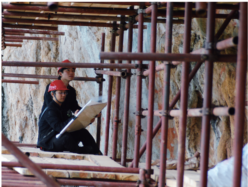
在危岩加固现场，工作人员对图像绘制留档
