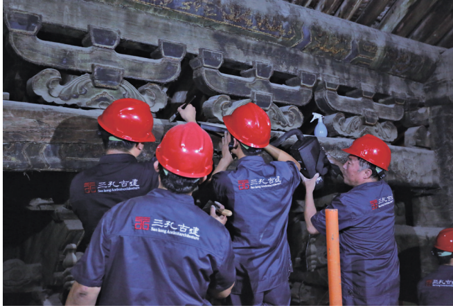
“三孔”古建筑技工修缮工作现场图
