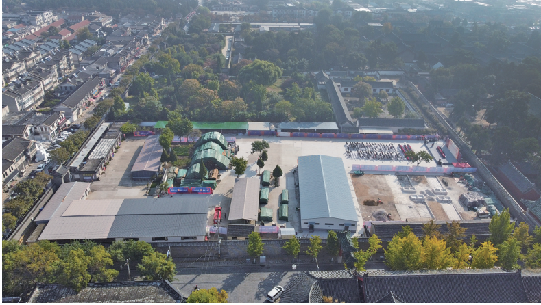
曲阜三孔古建筑工程管理处自备料场航拍图
