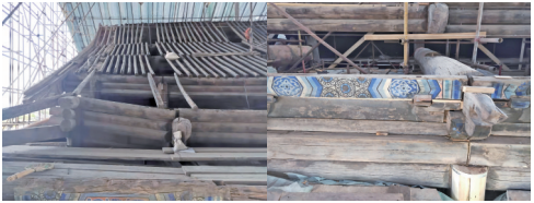
双步梁及三步梁整修加固前、后
