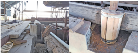
佛殿三层后檐墙内柱柱头整修加固前、后
