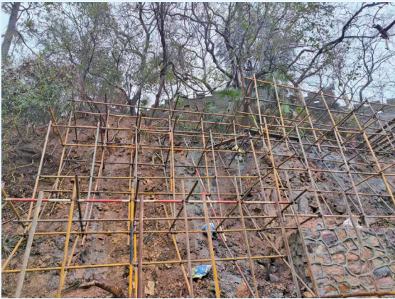
赤壁摩崖石刻危岩体整治工程
