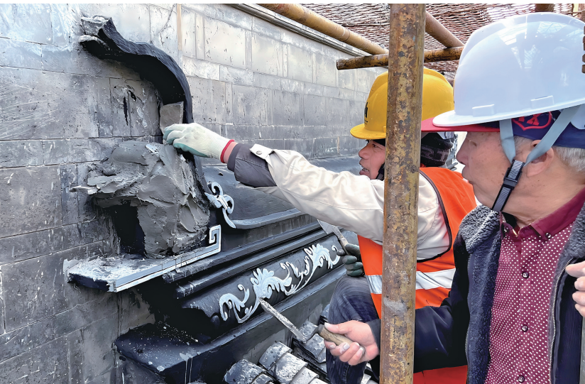
文物专家在施工现场指导检查
