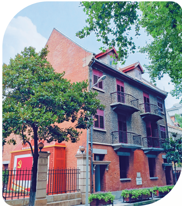
武汉中共中央机关旧址
