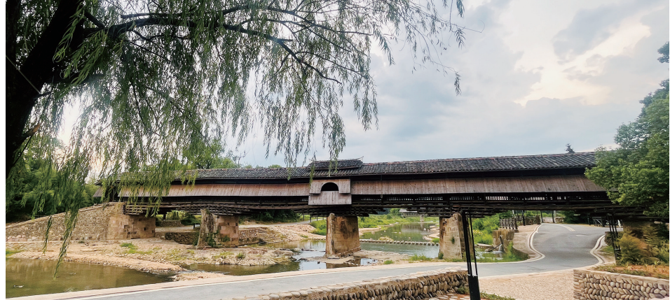
修复后的承安桥
