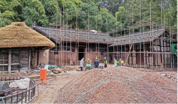
朱德同志旧居修缮现场
